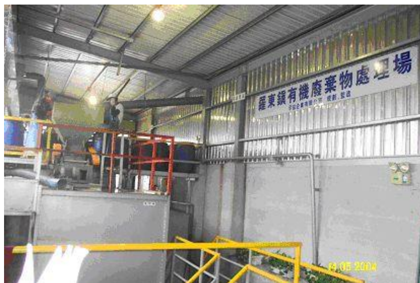
圖 1 羅東鎮密閉式廚餘有機堆肥場
