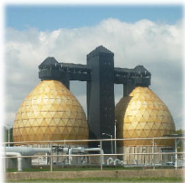
圖 後河廢水處理廠兩座蛋形消化器 (digester) · 連同六座地下消化器每日可處理廢水 14,000,000 加侖。 (照片摘自 http://www.chem.info/Articles/2010/04/Instrumentation-Half-Empty-or-Half-Full/ )
